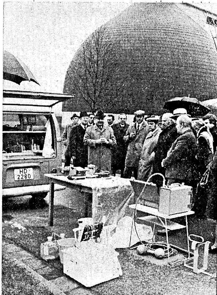
Mitglieder des Bauausschusses schnupperten am Entwässerungssystem. Links: Demonstration am Abwasseruntersuchungsfahrzeug. Rechts: das „Kanallernaue“ wird in die Unterwelt geschickt.
